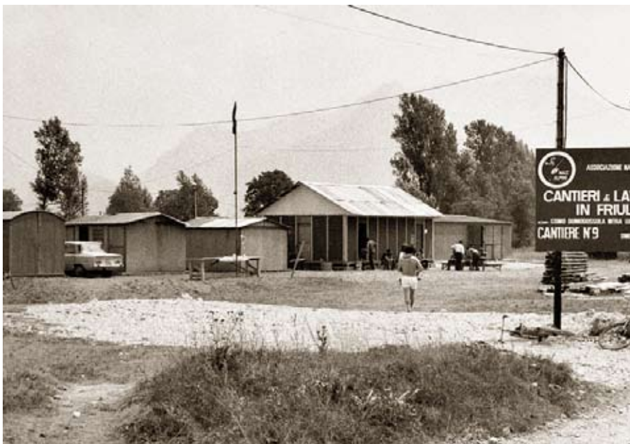
1976 Terremoto in Friuli - Gli Alpini della Sezione di Varese partecipano all'attività del Cantiere N° 9, a Cavazzo Carnico
